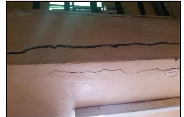
صورة (٥): شروخ في الجسر الحامل للترج نتيجة صدأ الحديد الداخلي وانتمسك الخرسانة.
