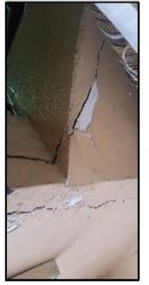
صورة (٣): شروخ في الدرج والجسر الحامل للم. صورة (٤): شروخ كفية نتيجة الأحمال أو الصدا بالمعدن.
