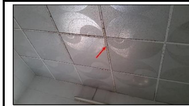
صورة (٢٤): جوانب السقف المستعز تحتاج إستبدال نتيجة صدها بسبب عواصف برور الرأس وقصر الإستخدام.
