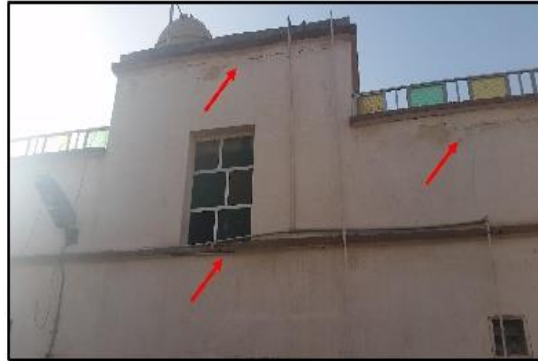
صورة (٢): شرخ أفقي في بروز نتيجة صدأ الحديد بالإضافة إلى شروخ وارش السطح رائد بيت الشرح.
